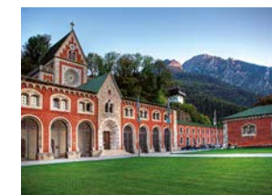
Alte Saline Bad Reichenhall
