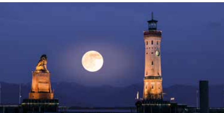
Hafeneinfahrt bei Nacht
